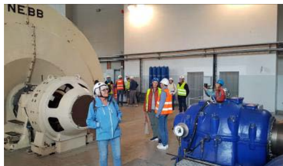
I stasjonshallen på kraftverket
